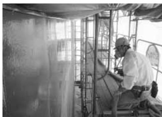
写真-4 超速硬化ポリウレタン塗膜吹付け
