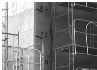
写真-5 防水完了
