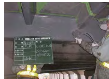
レジテクト100R1吹付状況
