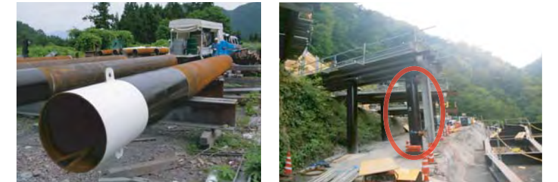
ライニング施工完了
