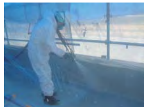
レジテクト5000吹付状況
