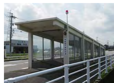
地下横断歩道外部上屋全景
