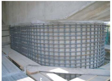
三重県内伊勢地区国道23号2橋脚耐震補強工事にコンクリート巻立ての保護としてS Q S（CVスプレー）工法が採用され4月に無事施工を完了致しました。
