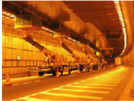
12台の高所作業車を効率よく配置し、交通規制時間内に計画面積の施工を完了しました
