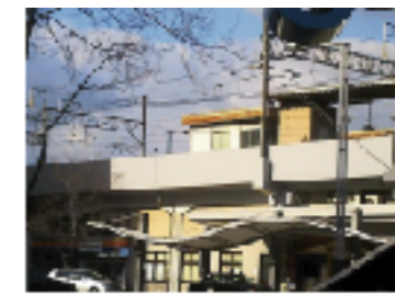
姪浜駅付近のRT工法完成現場
