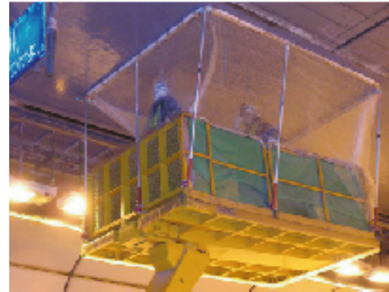
12台の高所作業車を効率よく配置し、交通規制時間内に計画面積の施工を完了しました
