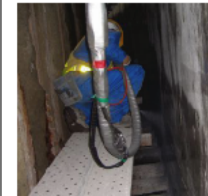
写真上：施工前 漏水が激しい 写真下：止水後CVスプレー施工
