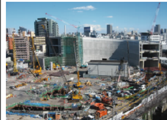
完成すれば地上35m地下36m、20階建てのビルに相当、1周400mループ道路2周して上り下りするジャンクションは巨大な楕円形になります
