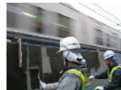
レジテクトPW-F(プライマー)施工
