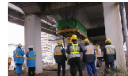
吹付け状況を注目するJR関係者
